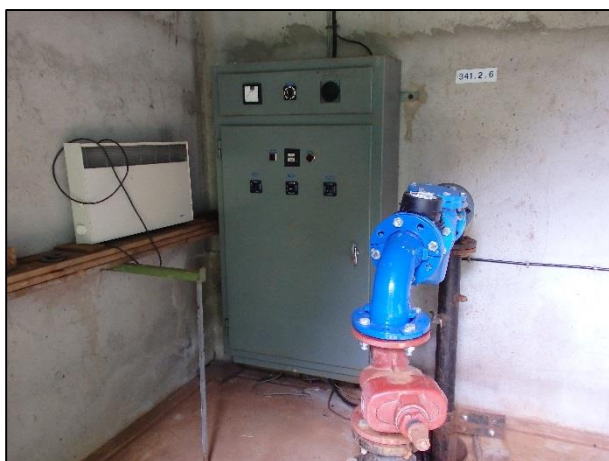
Tête de forage avec compteur
